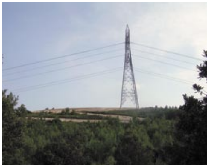
Les lignes électriques aériennes existantes ont déjà un fort impact sur le paysage
